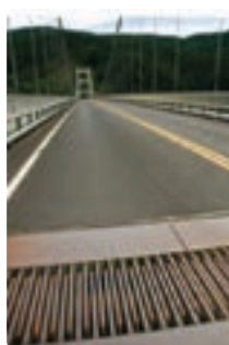
(ب) نمونه‌ای از بست‌های انبساطی
